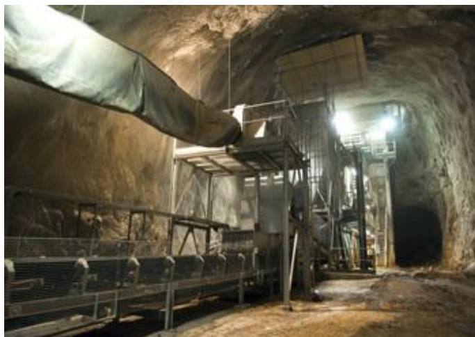
Figura 2. Estação primária em subsolo na pedreira Fassa para controle de poeira e ruído.
